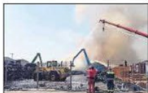
Aufräumarbeiten: Der blaue Bagger der Firma Lenhard im Einsatz.
